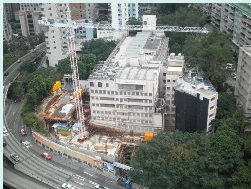
主樓工程工地眺望圖
